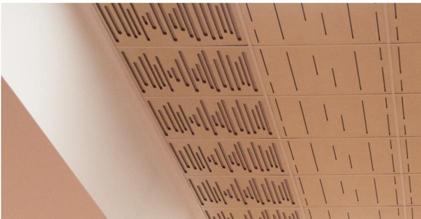
Sopra: la nuova illuminazione del palco, i pannelli fonoriflettenti Waveline BC ABS, l'innalzamento del boccascena e, di scorcio sulla sinistra, i pannelli Waveline piegati a forma di tegola e disposti a parabola. Sotto: particolare del soffitto dell'auditorium con i pannelli fonoriflettenti Waveline e, in prossimità delle travi, i pannelli fonoassorbenti Wavewood.
